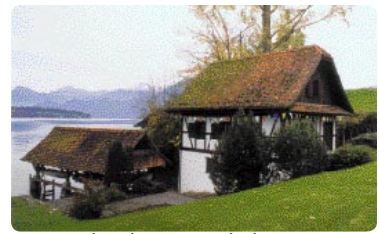
Gemeindegalerie Benzeholz, Meggen (beflaggt)
